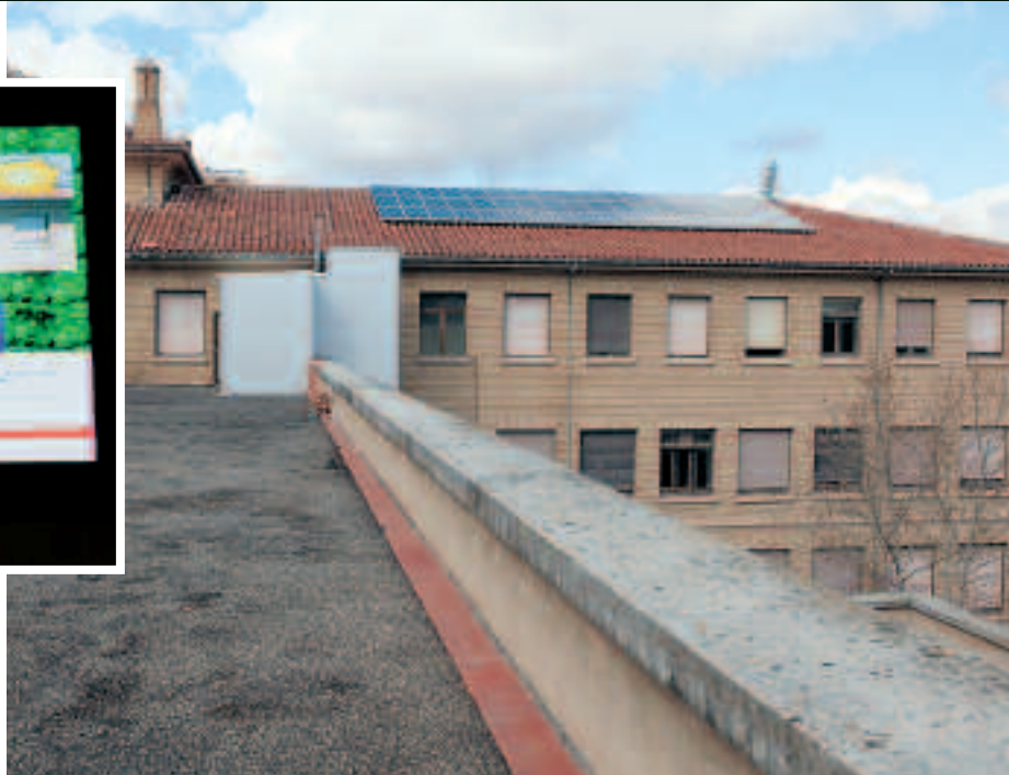
Placas solares en el tejado del instituto y panel instalado en el hall.
